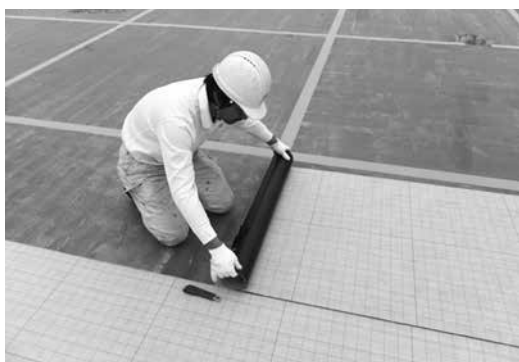
写真－３ 通気緩衝シート施工
