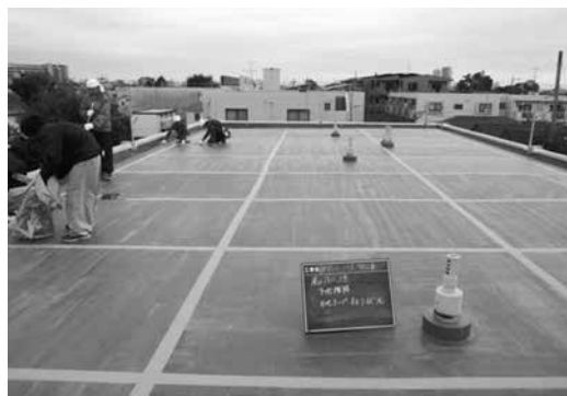
写真－２ 目地材施工完了
