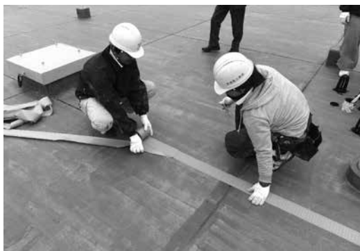
写真－１ 目地材施工
