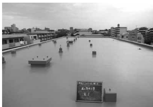
写真－４ 屋上防水工事完了
